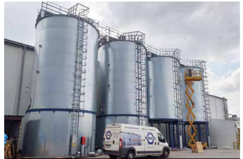
Silosy Hamechu służą do bezpiecznego magazynowania rozdrobnionego materiału (wióry, trociny itp.) powstałego w wyniku obróbki drewna. Fot. Hamech
