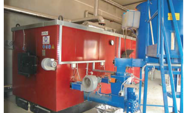
Układ sterowania automatycznie steruje podawaniem paliwa w oparciu o informacje uzyskane z czujników obecności paliwa.
