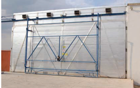
Drzwi załadownicze suszarni SK są typu płytowego, z możliwością przesuwu na bok komory.
